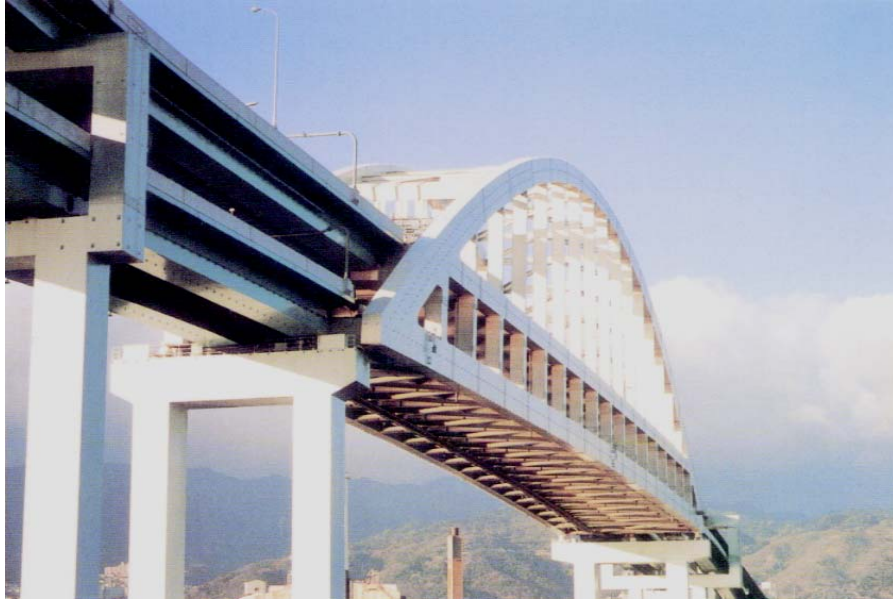
Rokko Oohashi Bridge
