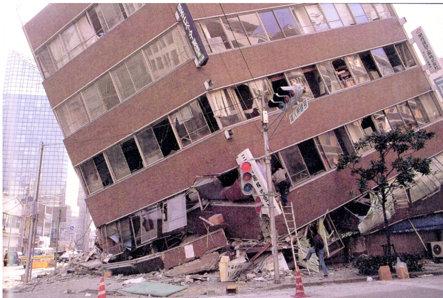
ピロティー形式構造の崩壊 朝日
